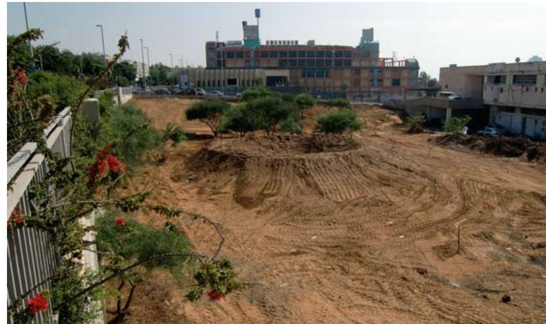
Fasi di costruzione dei crateri
